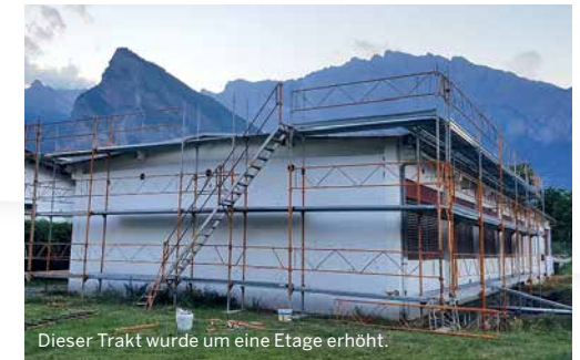
Dieser Trakt wurde um eine Etage erhöht.
